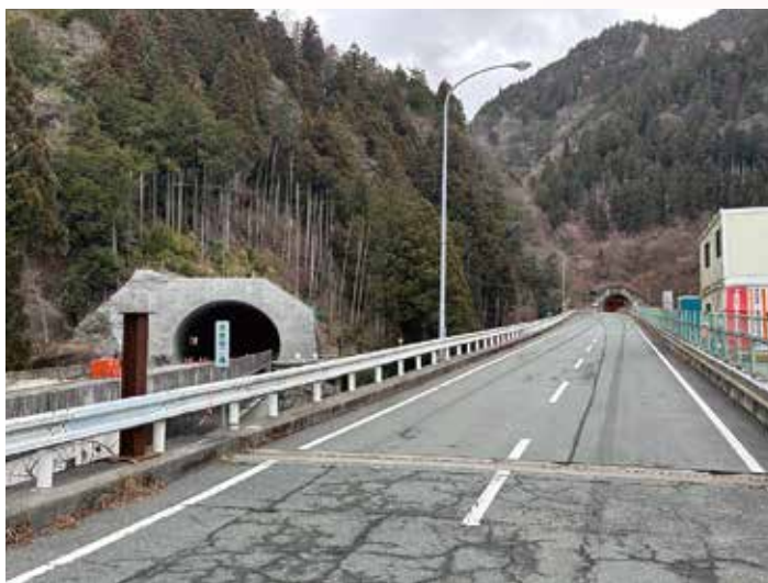
左側：青崩峠トンネル入口（工事中） 右側：草木トンネル入口
