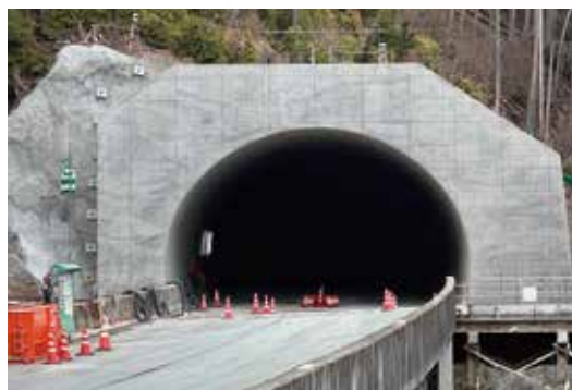
青崩峠トンネル 静岡県側入口 (工事中)
